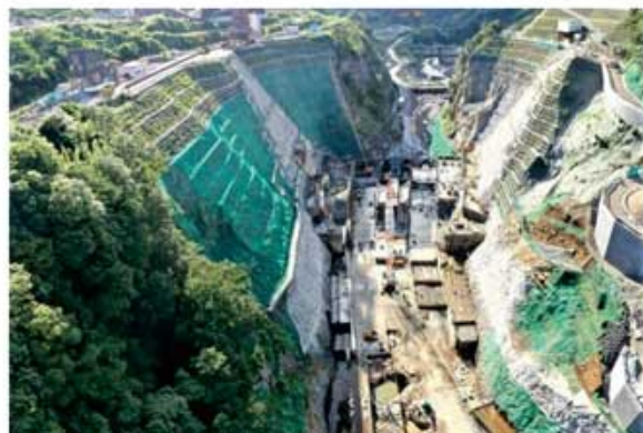
建設中の立野ダム(2023年完成予定)
